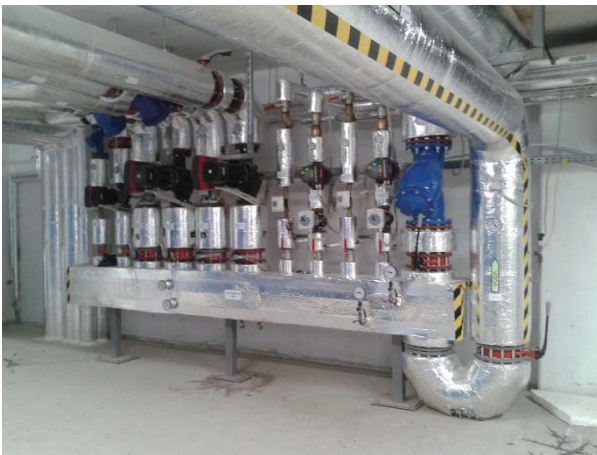
Realizácia – napojenie rozdeľovača
