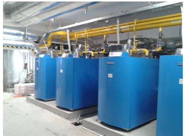
Realizácia – napojenie kotolne
